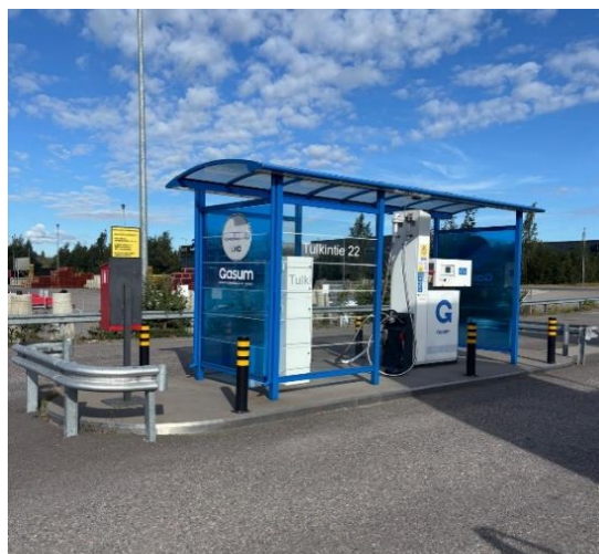
Kuva 8. LBG-jakelumittarisaareke törmäyssuojakaitein.
