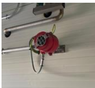
Bild 6. Låga- och gasdetektor.
