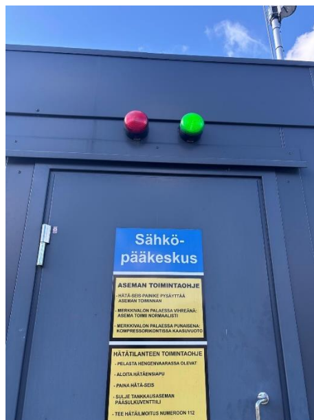
Bild 8. Varningslampor för gasläckage.
