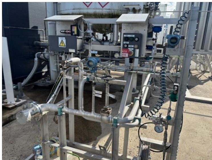
Bild 4. Påfyllningsstället för LBG-tanken.
