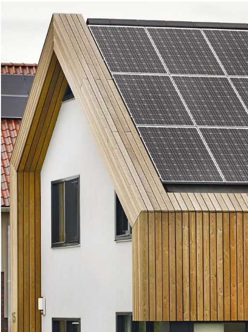
Solpaneler bör inte installeras på trätak eller gröna tak, som vanligen inte uppfyller kraven för klass BROOF(t2). (Foto till vänster: Droomhuis och foto till höger: Pia Zanetti)
