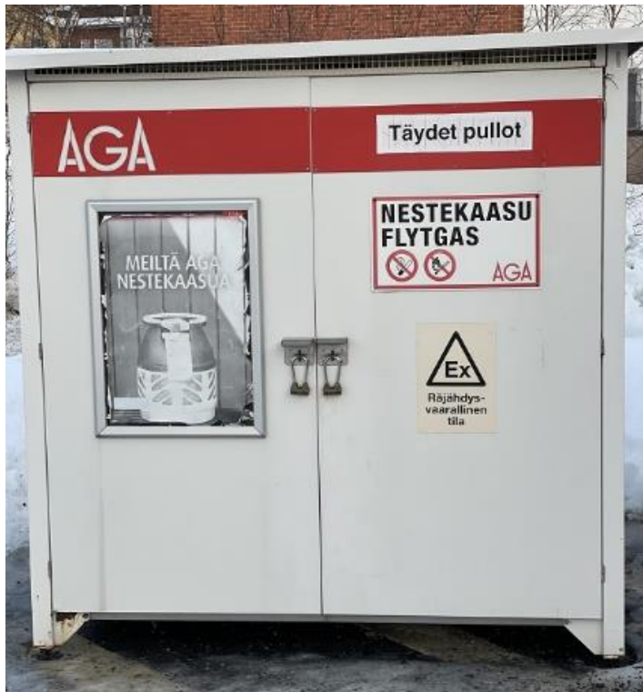
Kuva 2. Esimerkki kaasupullokaapista, jossa on lukitus ja kaikki tarvittavat merkinnät.
