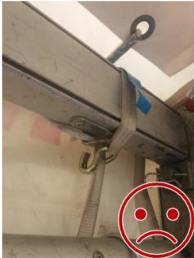
Bild 9. Spännbandet skärs av när det spänns.
