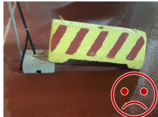
Bild 4. Spännbandets friktionslås är svagt. Den mindre vikten kan röra sig, vilket leder till att den större vikten faller och medför fara.
