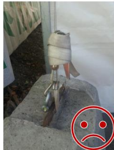
Bild 8. Det finns ett schackel, men den här har inte använts för fastsättningen. Kroken lossnar när konstruktionen fjädrar.
