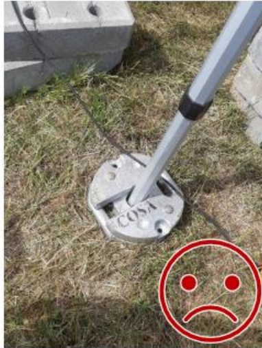
Bild 3. Låsning av motvikterna saknas. Det enda som håller fast tyngderna vid varandra är tyngdkraften.
