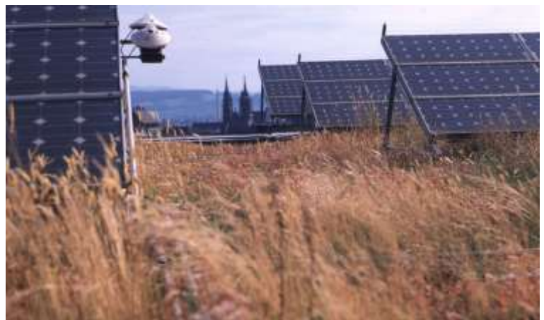
Solpaneler bör inte installeras på trätak eller gröna tak, som vanligen inte uppfyller kraven för klass Broof(t2). (Foto till vänster: Droomhuis och foto till höger: Pia Zanetti)
