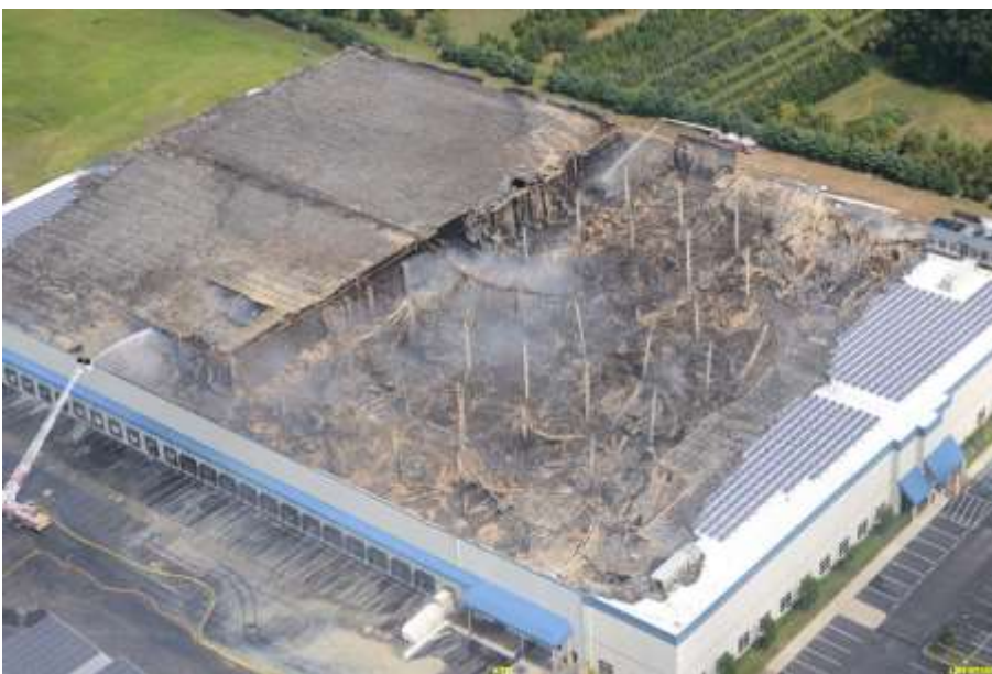
Brand i fotoelektriskt solenergisystem i New Jersey 2013 i en lagerbyggnad med fler än 8 000 solpaneler på taket (Milke et al. 2014, 4–5). (Foto: Reax Engineering)
