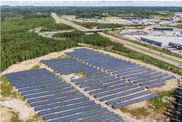
Solpanelsfält i Lempäälä. (Foto: Aamulehti)
