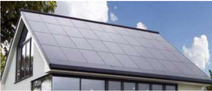
Solpaneler integrerade i taktäckningen (Foto: Solarguide)
