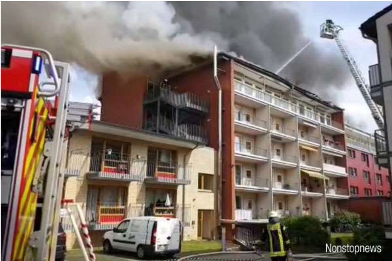
Brand i fotoelektriskt solenergisystem i en tysk vårdinrättning/äldreboende 2019. I eldsvådan evakuerades 96 boende från vårdinrättningen. Till följd av rökexponering behövde 21 personer vård, varav 2 var brandmän (Feuerwehr-Magazin 2019). (Foto: Feuerwehr-Magazin/Nonstopnews)
