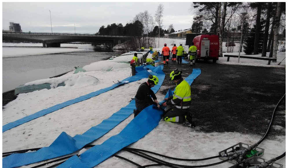
Kuva: Mika Haverinen Oulu-Koillismaan pelastuslaitos. Kuvassa harjoitellaan tulvaletkulinjan rakentamista
