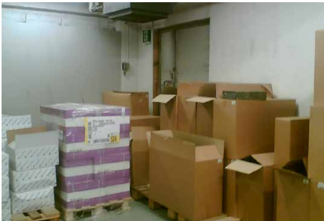
Kuva 14. Uloskäytävän käyttö on estetty varastotavaroilla.
