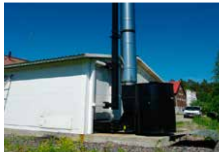
Tutkintakohde oikealta takakulmasta
