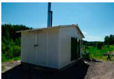
Tutkintakohde vasemmalta etukulmasta
