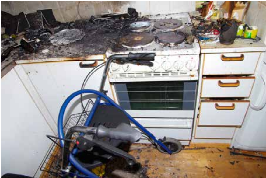
Palontutkinnassa havaittiin, että huoneiston asukkaan käyttämän rollaattorin jarrukahva oli samalla korkeudella liedien katkaisijoiden kanssa.
